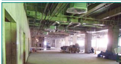
1階の外科系外来＆待合いホール。突き当たりが救急搬入口です。
